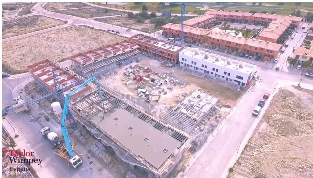
Situación actual de las obras de Kiruna donde se ha presentado hoy el nuevo piso piloto
